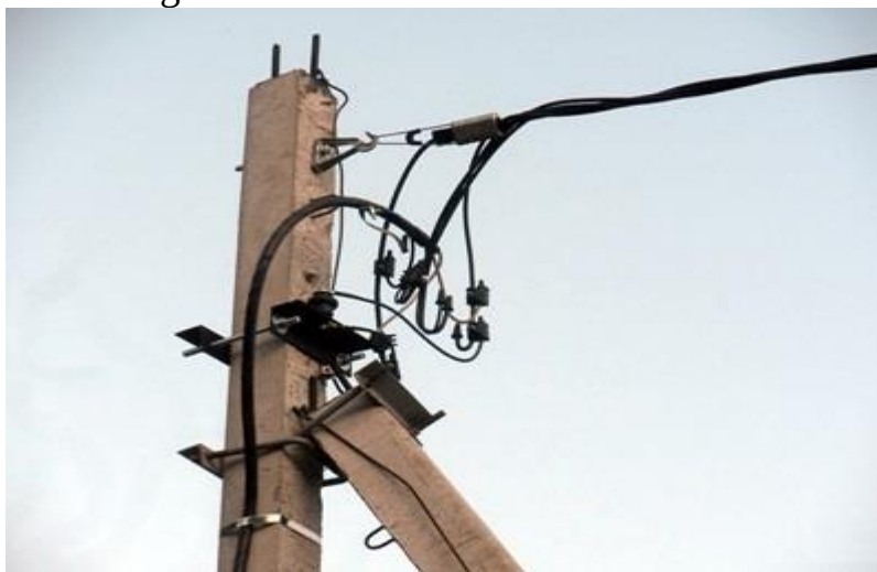
1-расм. Оптик кабелларни таянч устунларга осилишининг умумий кўриниши
