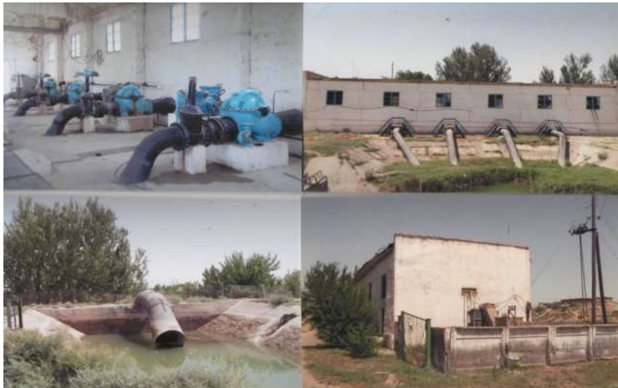
1-rasm. Nasos stansiyaning umumiy ko‘rinishi.
