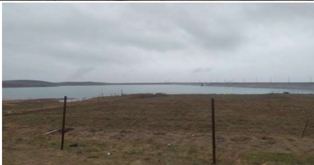
2-rasm. Langar suv omborining umumiy ko'rinishi.
