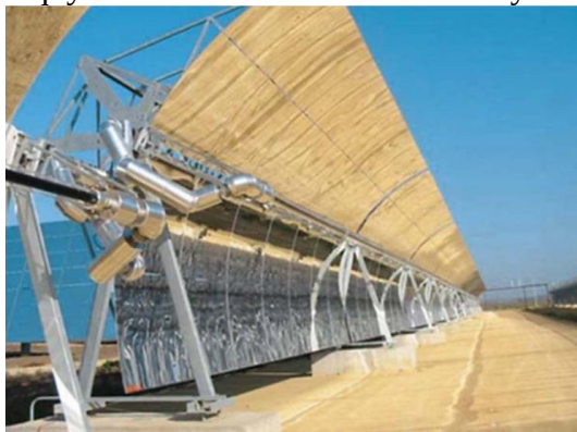
5-rasm. Parabolotsilindrik konsentratorli energetik qurilmaning umumiy ko‘rinishi.
