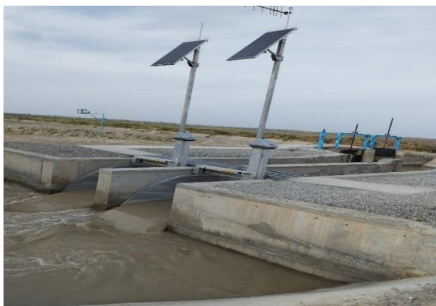
1-2-rasm. Qamashi-Mirishkor kanalida o'rnatilgan "Rubicon Water" suv obyektlarini avtomatlashtirish tizimi
