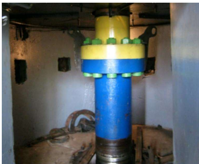
1, 2 – верхняя и нижняя крестовины; 3, 5 – верхний и нижний направляющие подшипники насоса; 4 – камера РК
