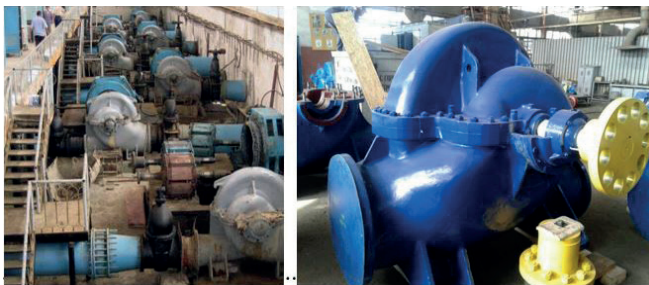
Рис.1. Компоновка насосных агрегатов НС «Нарпай».
