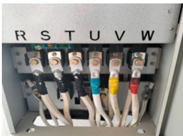
Рис. 1-2. Процесс установки преобразователя частоты для плавного пуска электродвигателя на насосной станции «Кунгир-2» Камашинского района
