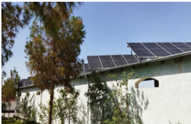
Рис. 3-4. Солнечная электростанция мощностью 30 кВт установлена для административного здания на территории «Управления насосных станций и энергетики при Аму-Кашкадарьинском бассейновом управлении ирригационных систем»
