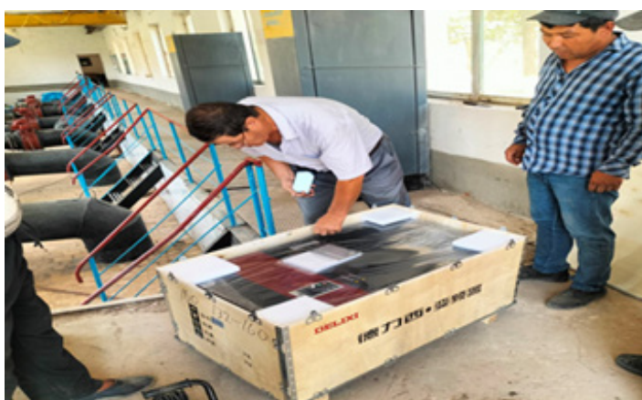
Рис. 1-2. Процесс установки преобразователя частоты для плавного пуска электродвигателя на насосной станции «Кунгир-2» Камашинского района
