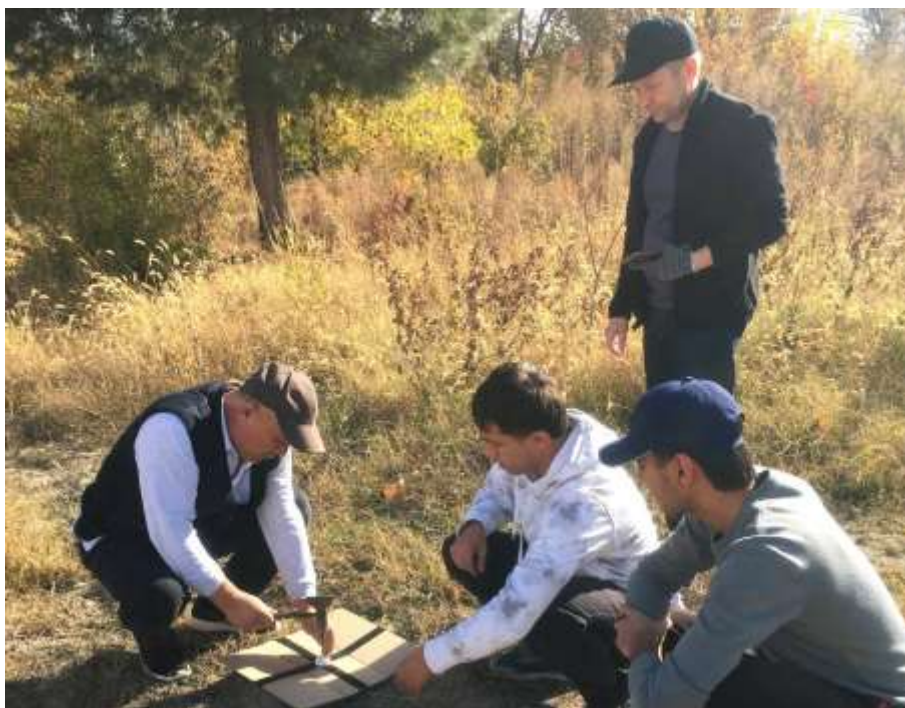
Рис. 1. Закрепление на местности опорных геодезических пунктов
