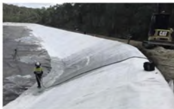
2-rasm. "Beton kanvas" kompozitsiyasini suv bilan emdirish. Germaniyadagi loyiha, 2017 yil
